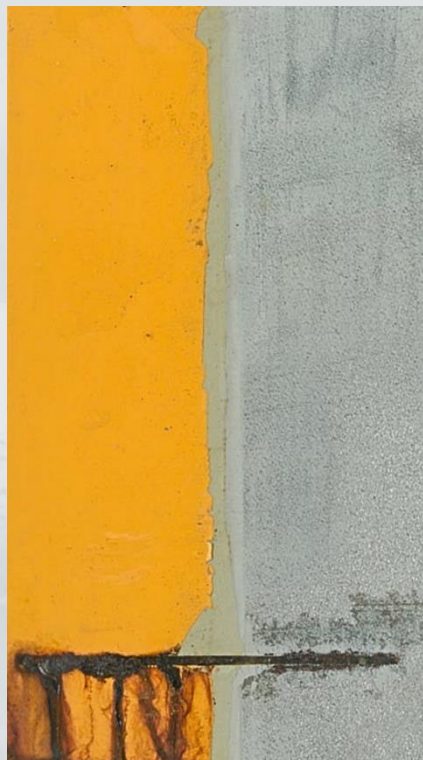
Top coat – remoção com solvente
